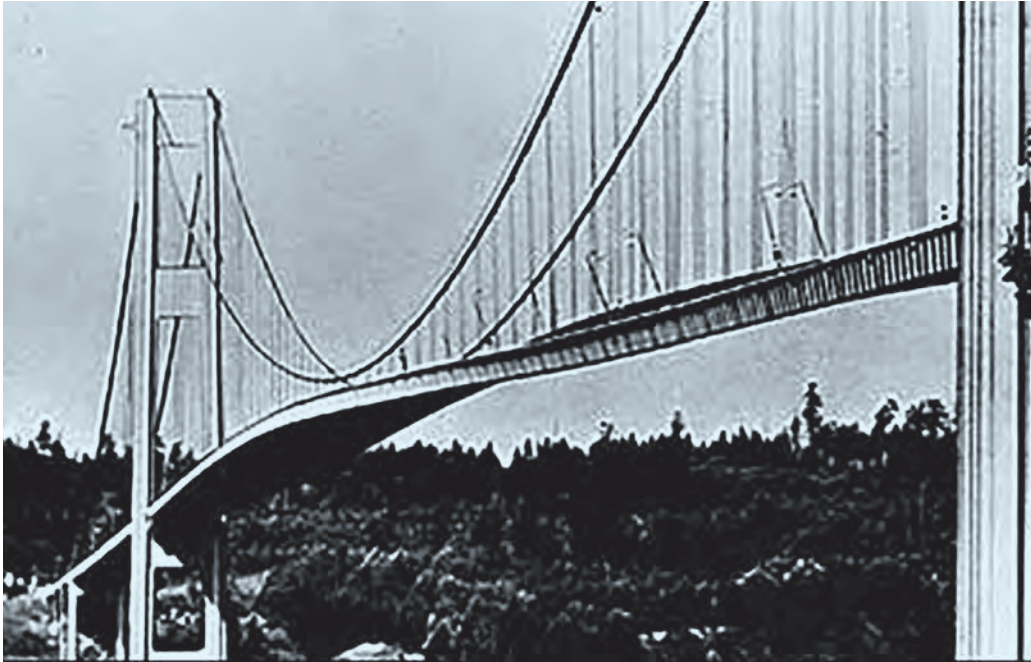
Figuur 1.2 Trillingen met grote amplituden van de ‘Tacoma Narrows Bridge’ vlak voordat de brug instortte in 1940.
